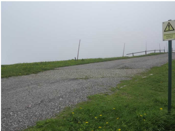
Obr. č. 3. Pohľad na dlažbový pás pri križovaní podzemného vedenia VN na konci trasy pred vysielacom.
