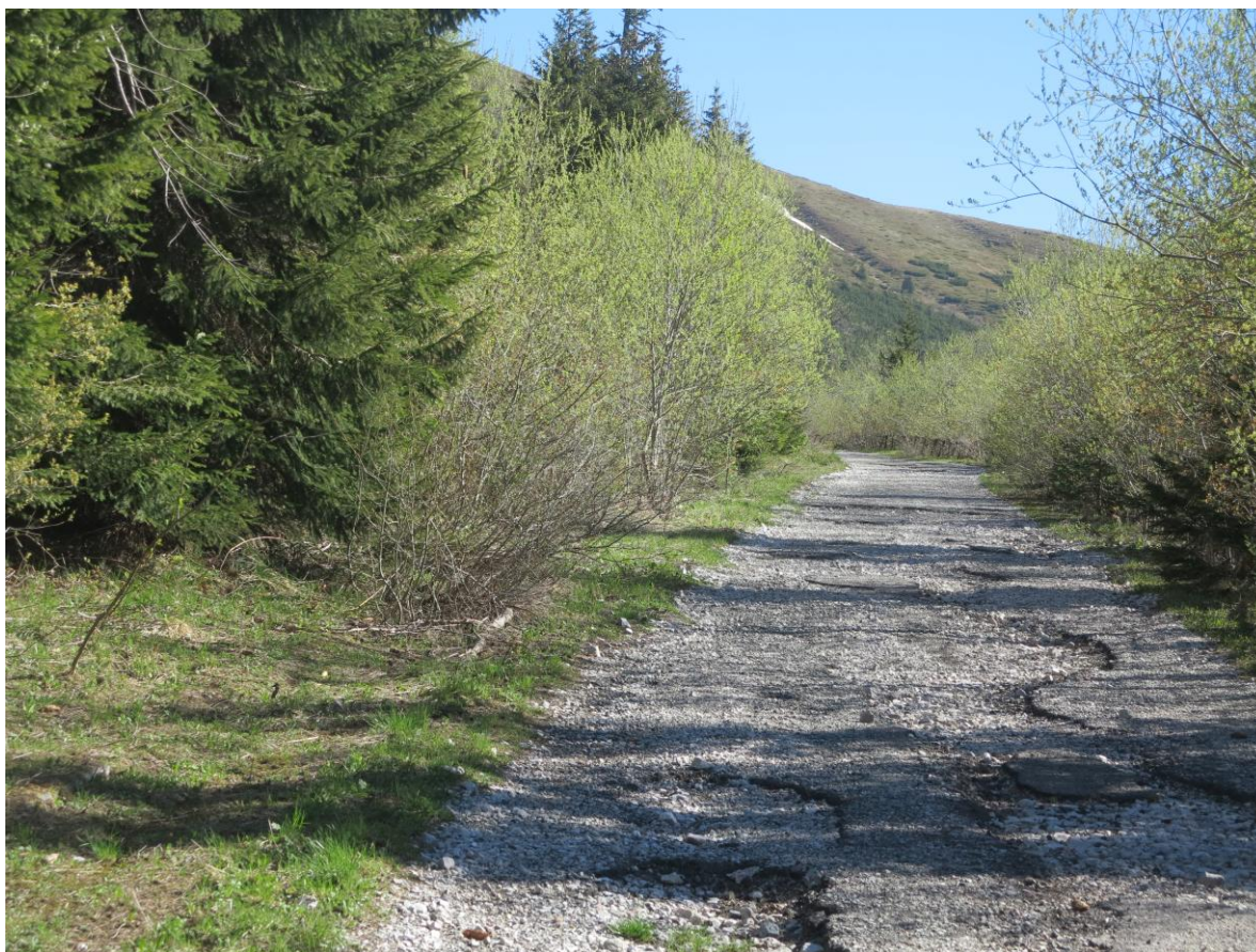
Obr. č.2. Pohľad na asfaltovú vozovku havarijnom stave celopločne deštruovanú tečúcou vodou.
